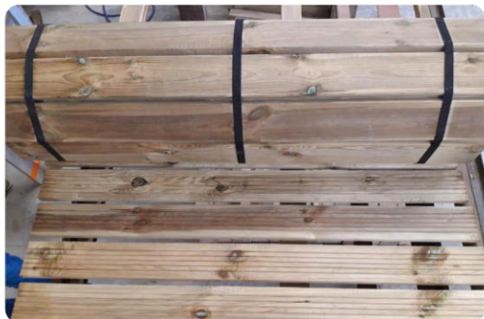
Platelage assemblé sur sangles
