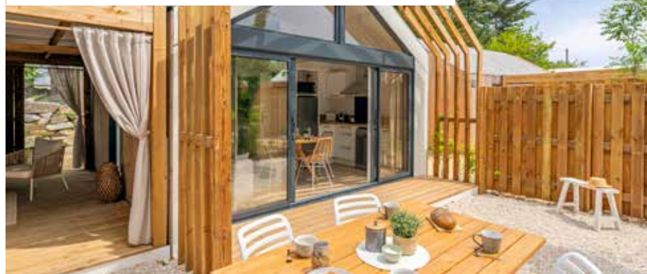
Menuiserie, murs ossature bois et bardage - Camping La forêt (85)
