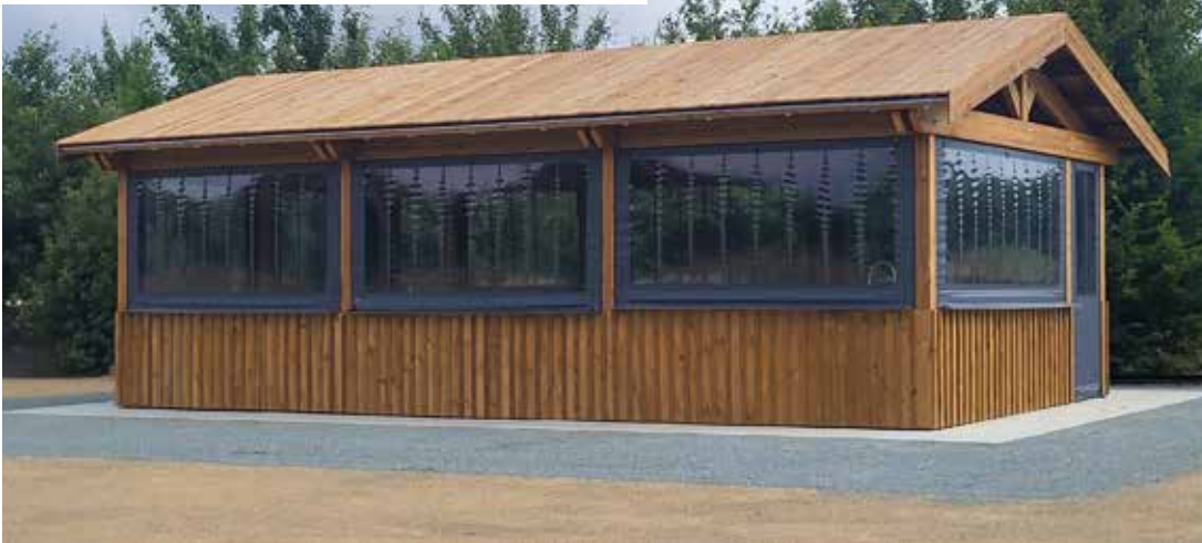
Ossature bois, charpente, couverture, bardage, menuiserie. Projet privé (85)
